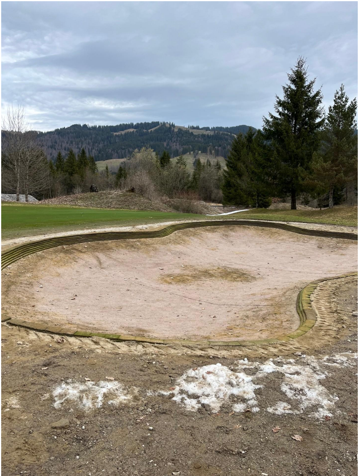
Loch 7 Bunkerwände am Mittwoch 25.03.2023 gebaut
