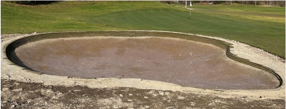
Wände/Walls Durabunker (Kunstrasen) Loch 4
